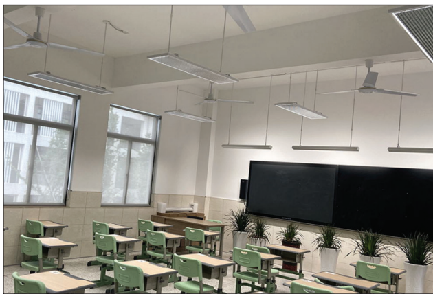
Рис. 3. Внедрение системы постоянной освещенности PEAN-B2 + датчик Pairui PR-MS10 в школьных классах
